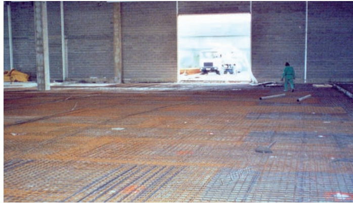
Mise en place des armatures.
