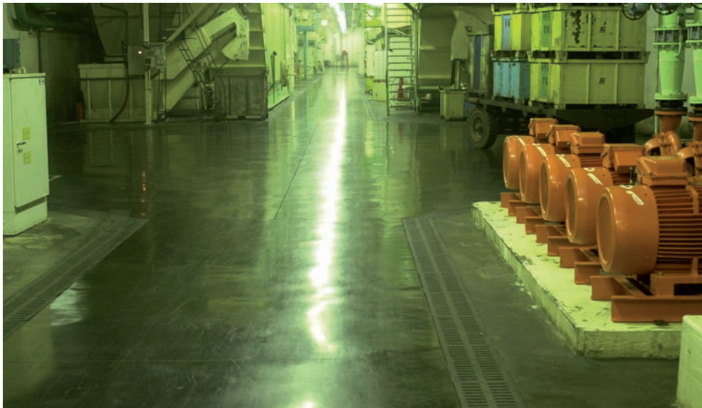
Dallage d'une unité de fabrication.
