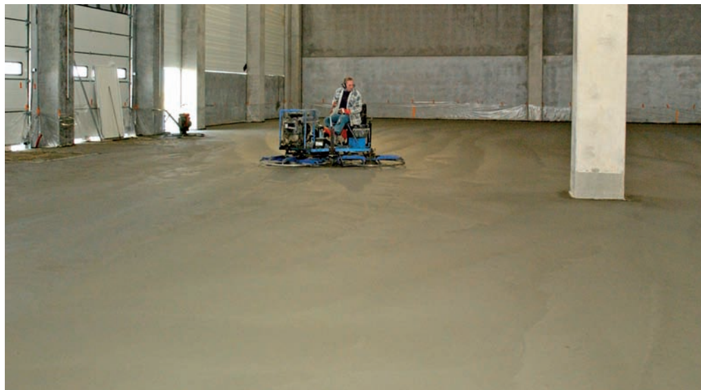
Finition de la couche d'usure.
