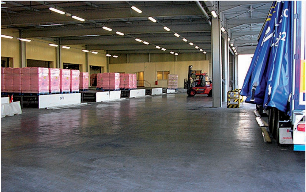
Dallage d'une zone de chargement.
