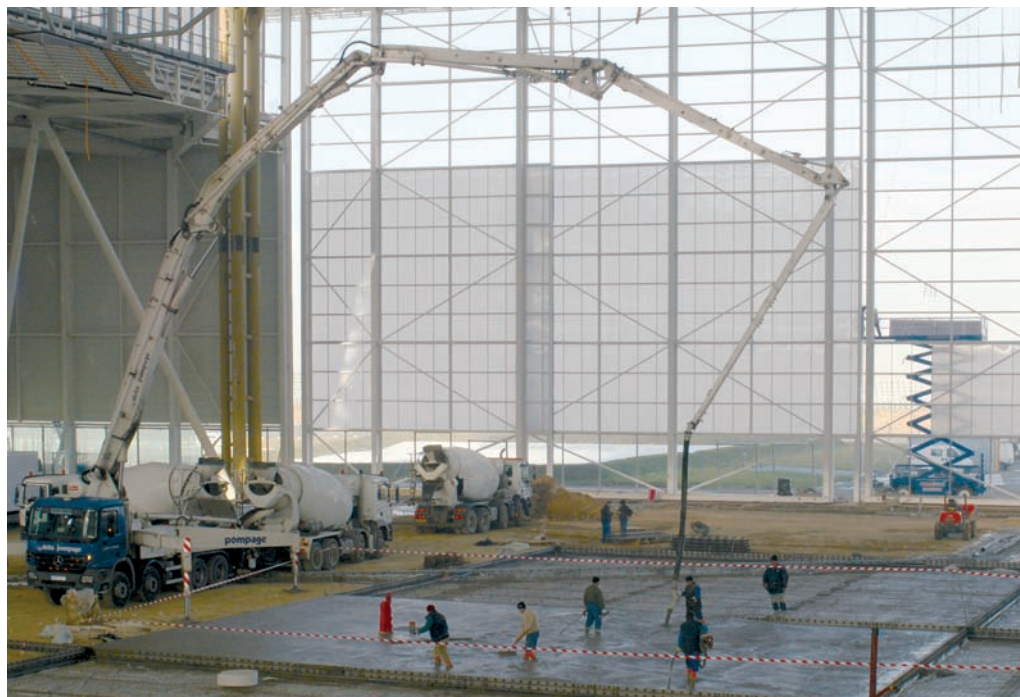
Pompage du béton.
