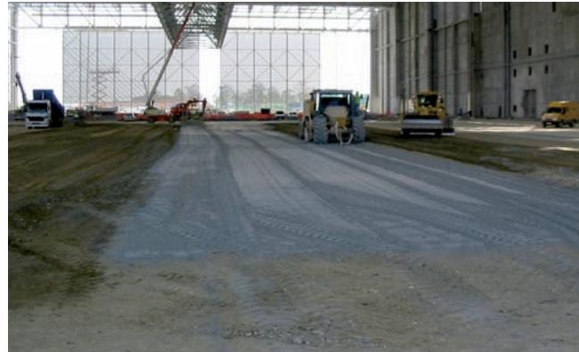
Traitement d'une couche de forme aux liants hydrauliques routier ou au ciment. Hall d'assemblage de l'A380, Toulouse.
