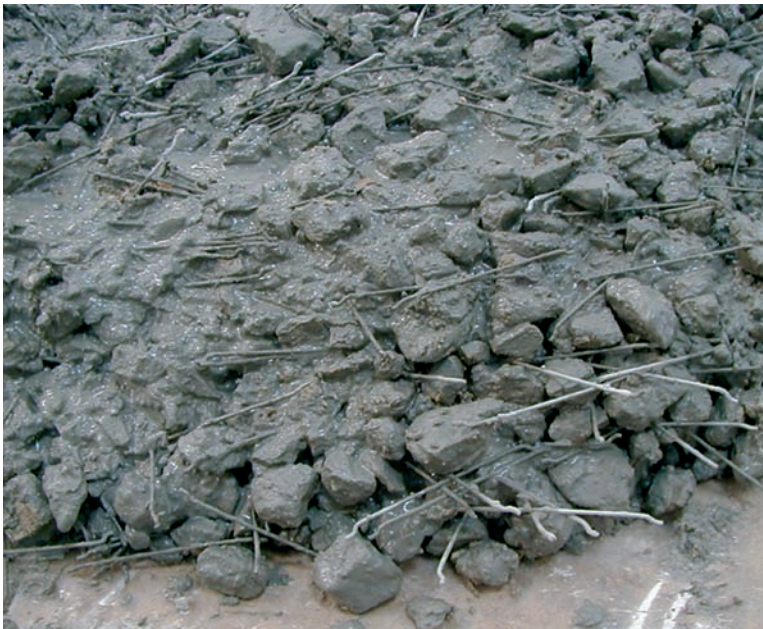
Béton de fibres métalliques.
