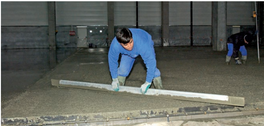
Dressage manuel. Béton de consistance S4.
