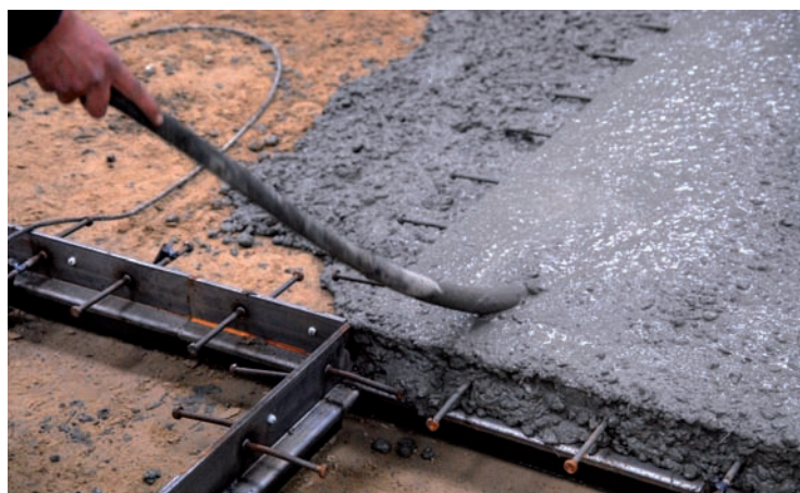
Joints d'arrêt de coulage et vibration du béton.
