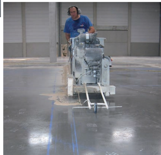
Sciage des joints de retrait.
