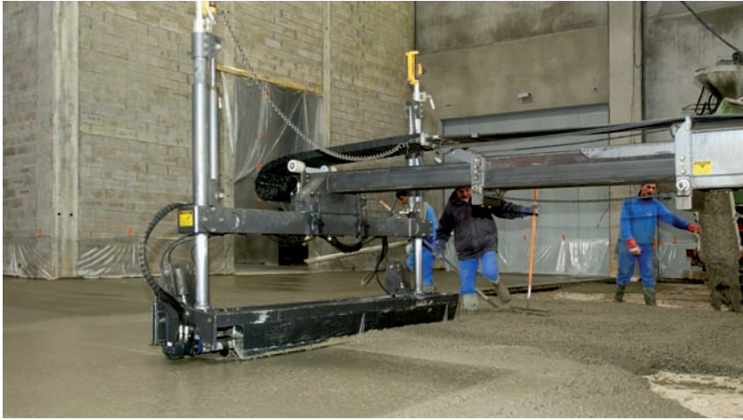
Dressage mécanique. Béton de consistance S3 minimum.
