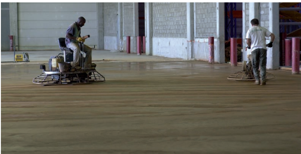
Talochage et lissage mécanique du béton.
