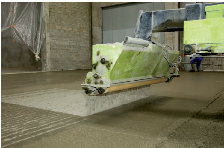
Épandage mécanique.
