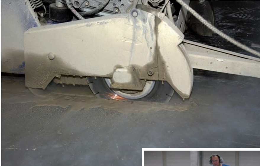
Sciage des joints de retrait.
