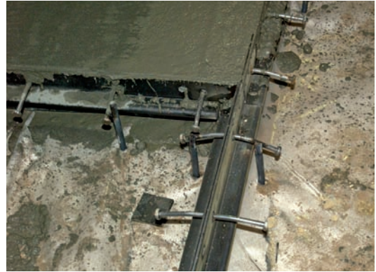
Système de joint d'arrêt de coulage.
